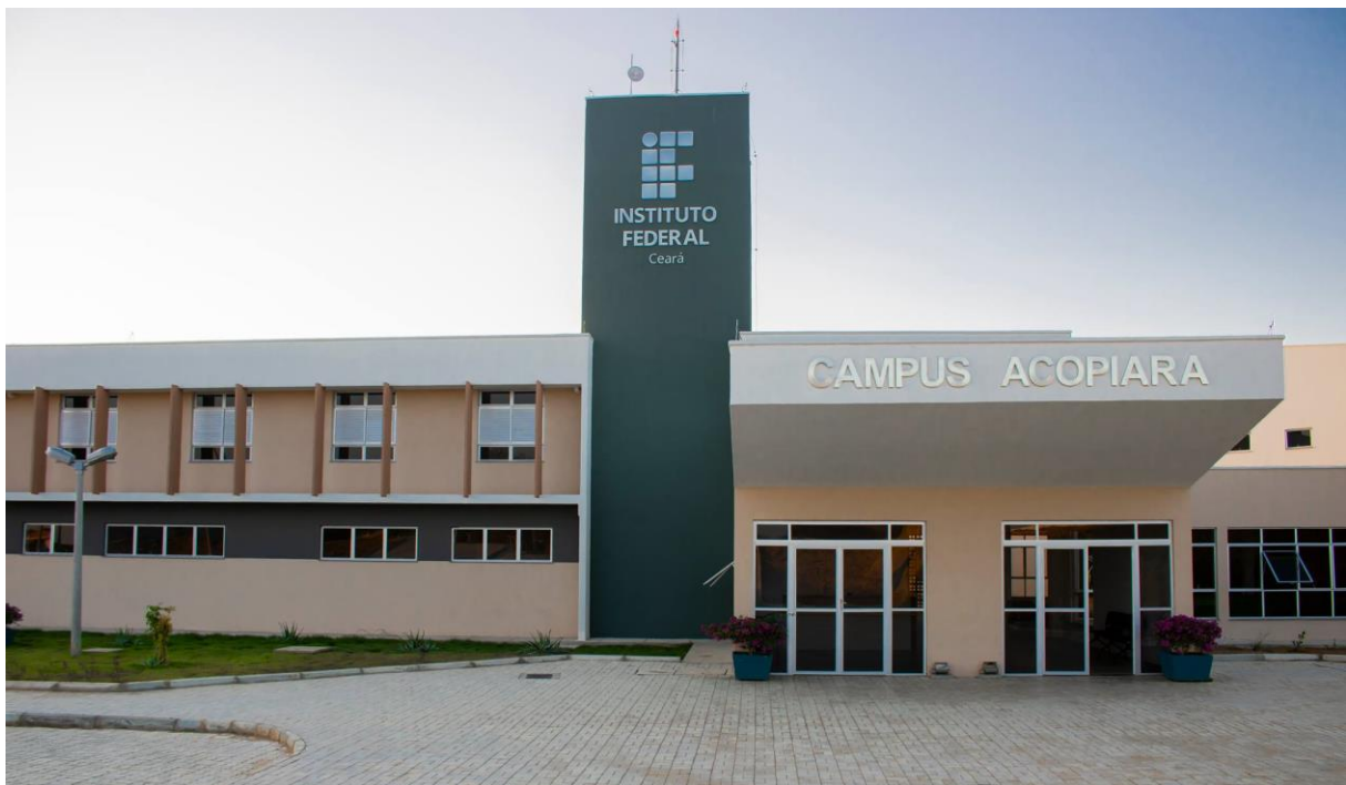
Figura 2 – Fachada do IFCE Campus Acopiara
