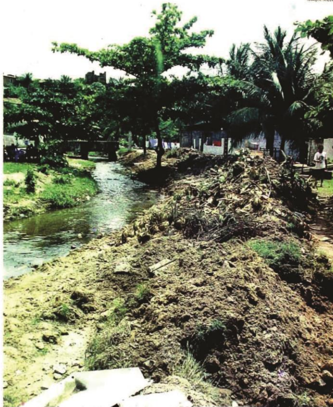
Limpeza do riacho Maceió foi realizada, mas o entulho deixado no local: risco de novo alagamento
