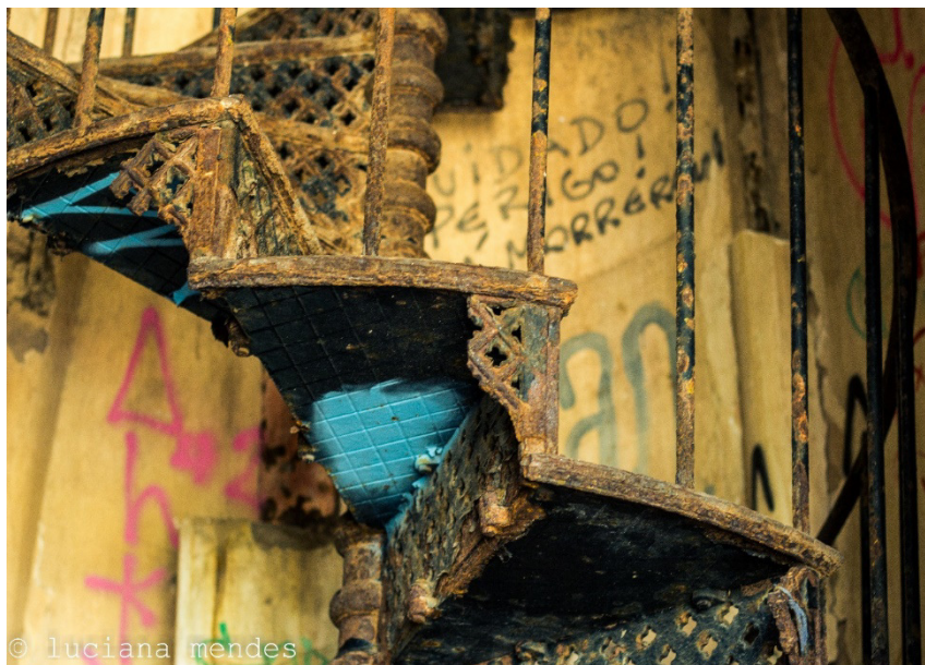
Foto 18- Parte da escada do antigo farol do Mucuripe
