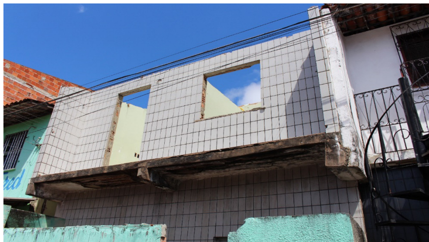
Foto 13 - Casas demolidas na Rua Córrego das Flores, Bairro Vicente Pinzon
