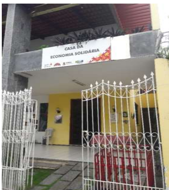
Figura 17 – Fachada da Casa de Ecosol
