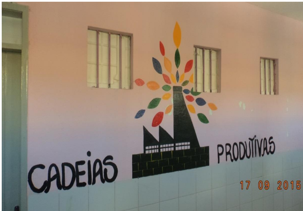
Figura 13 – Corredor onde estão instaladas as unidades fabris dentro do IPFDAMC
