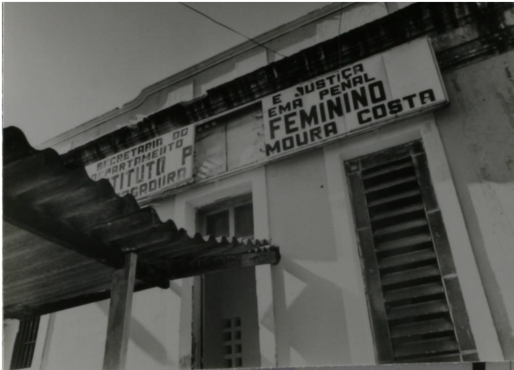
Figura 9 – Fachada do primeiro prédio do IPFDAMC fotografada em 08.09.1994
