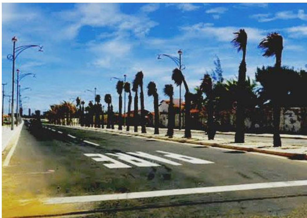
Foto 04— Rua Bernardo de Castro Feitosa em cuja confluência com a rua Sabiaguaba será construída a rotatória posicionada no início do trecho da via projetada
