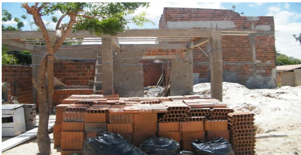
Figura 35 – Casa em construção na Nova-Jeri lote “doado” pela Prefeitura
