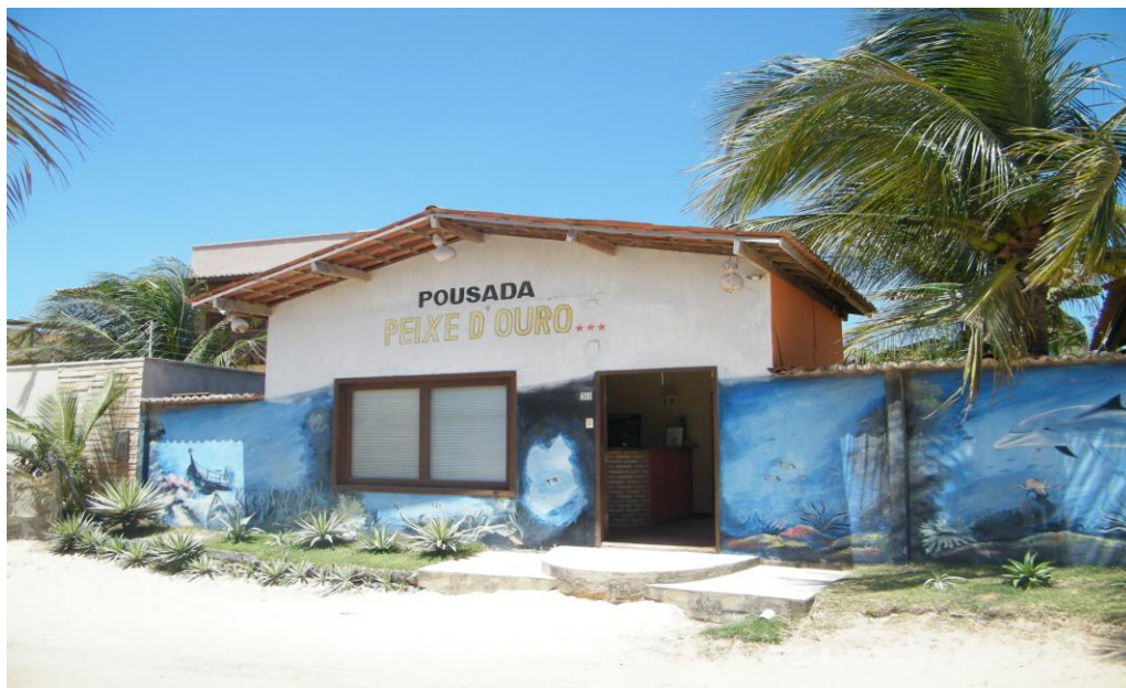
Figura 22 – Pousadas Peixe D'ouro e obras de ampliação
