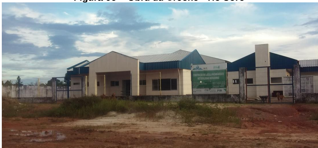
Figura 06 - Obra da Creche “Tio Soró”
