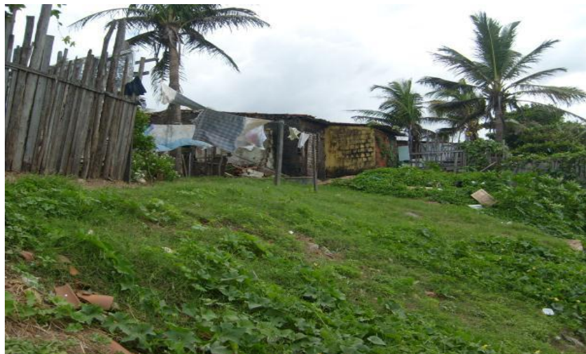
Figura 12 – Habitação em área de risco (encosta) no Pirambu B
