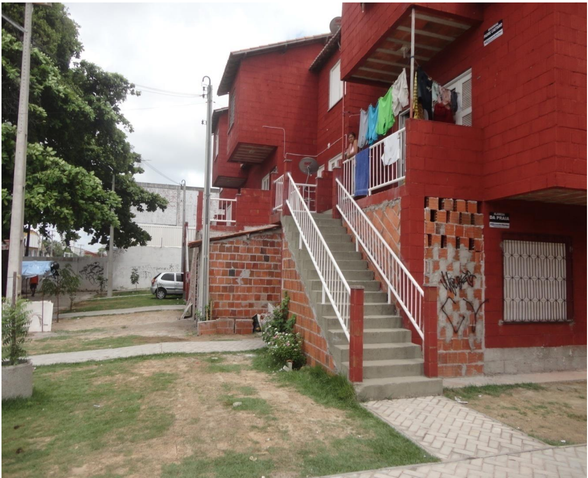
Figura 16 – Conjunto Habitacional Padre Caetano – detalhe de ampliação informal
