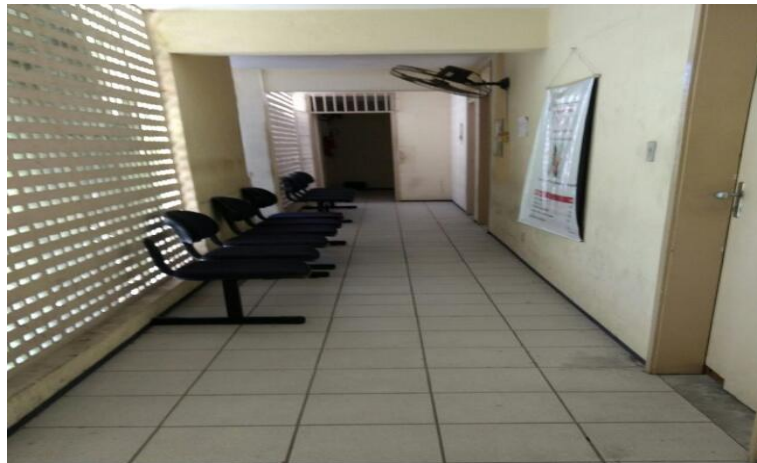
Figura 03 –Corredor de acesso às salas em desuso e à cela
