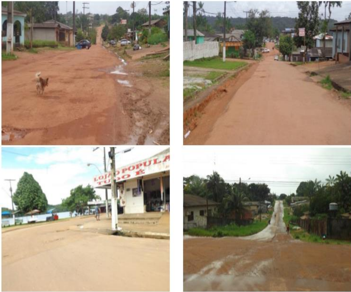
Figura 11- Fotos do centro da cidade do Oiapoque mostrando aspectos da estrutura da drenagem de manejo de águas pluviais
