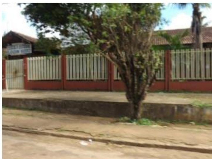
Figura 10- vista da Escola Estadual Joaquim Nabuco em Oiapoque.
