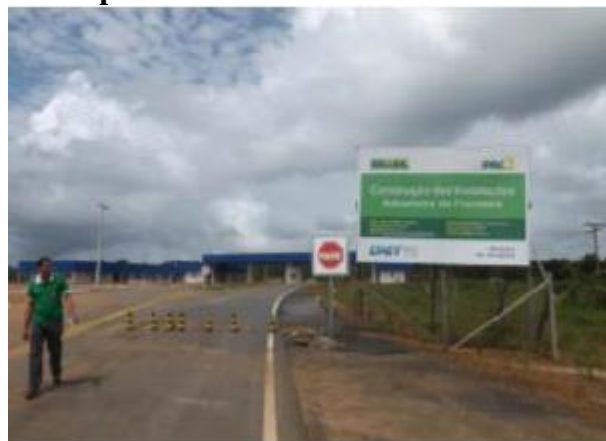
Figura 5- Vista panorâmica da Aduana Brasileira no Oiapoque
