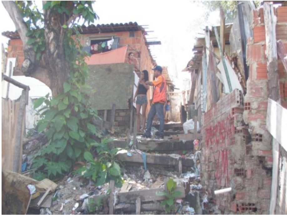
Figura 21 – Casebres na Rua Dunas do Alto
