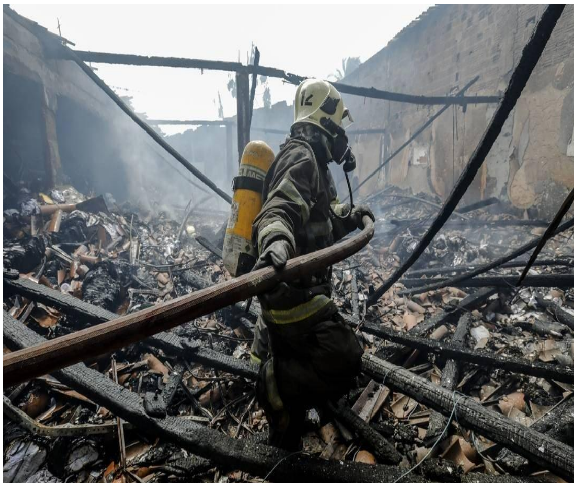
Figura 33 – Destruição dos ataques incendiários (unidade do SINE)
