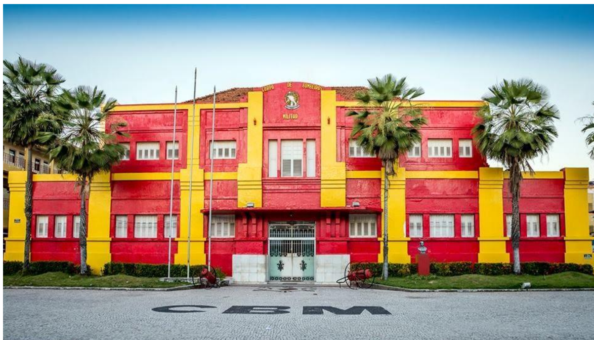
Figura 26 – Fachada do Quartel do Comando Geral do CBMCE
