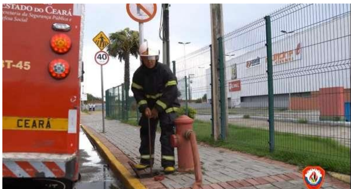
Figura 46 – Conexão entre um hidrante e uma viatura
