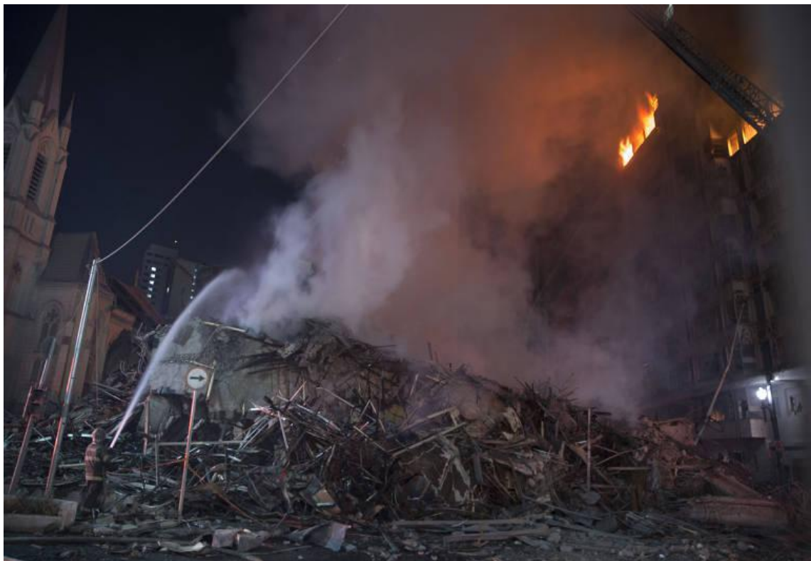
Figura 1 – Incêndio no edifício Wilton Paes de Almeida
