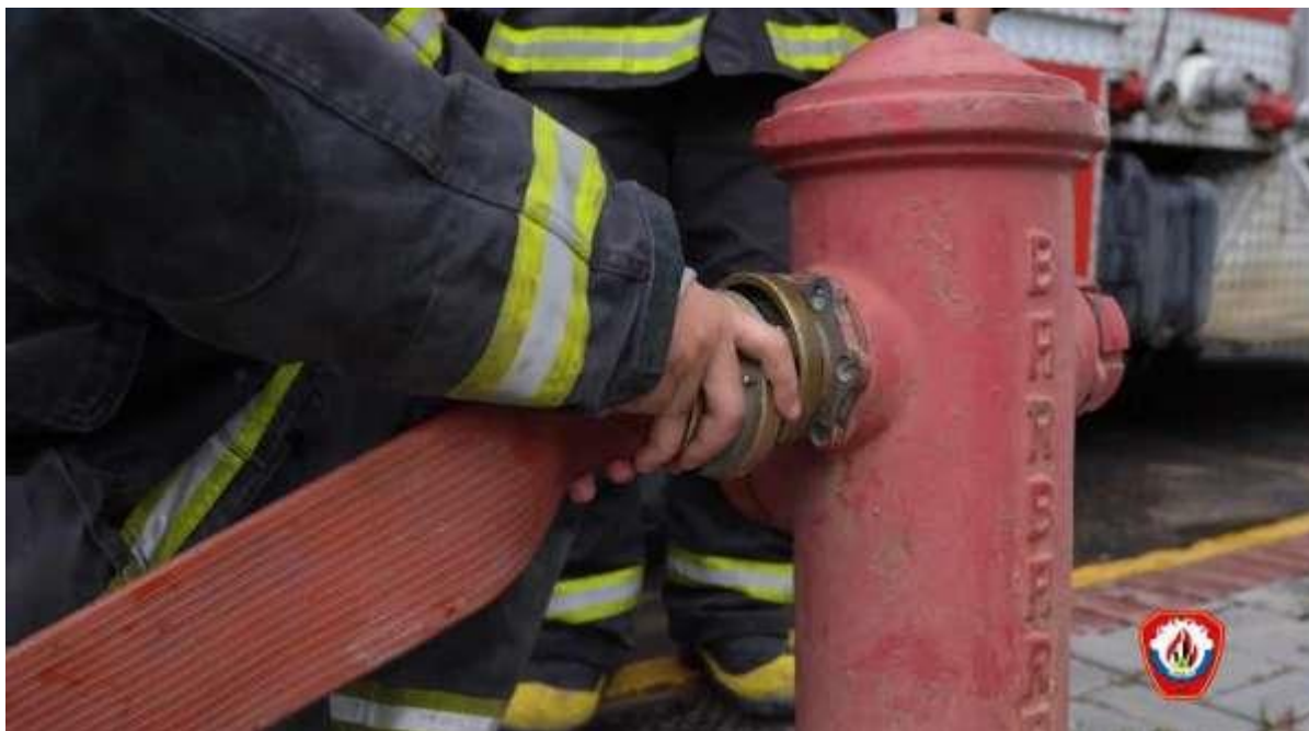
Figura 45 – Conexão de mangueira em hidrante de coluna
