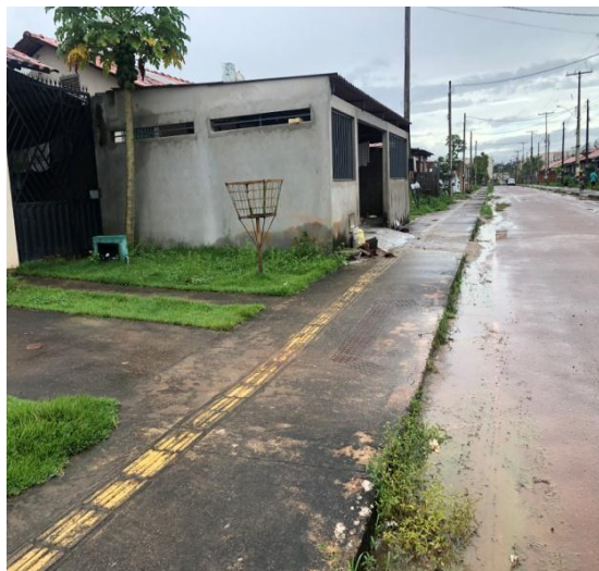
B) Piso escorregadio em razão de lodo
