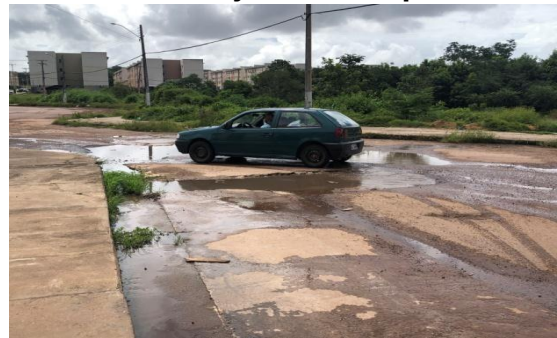
B) Vias danificadas com esgoto aberto
