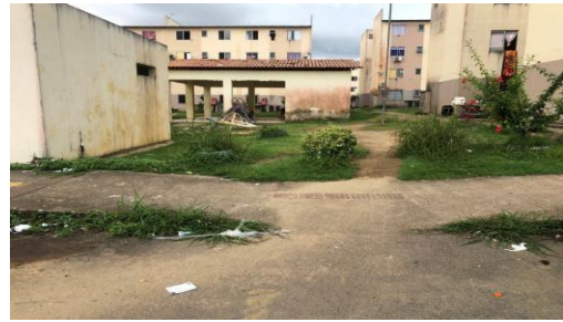
B)Desvio de calçada
