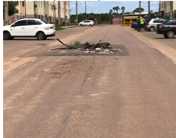
D) Vias com entulhos
