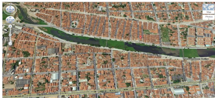
Figura 13 – Vista aérea da Comunidade do Lagamar
