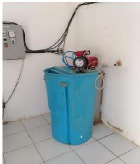
Figura 8: Tanque de Dosagem
